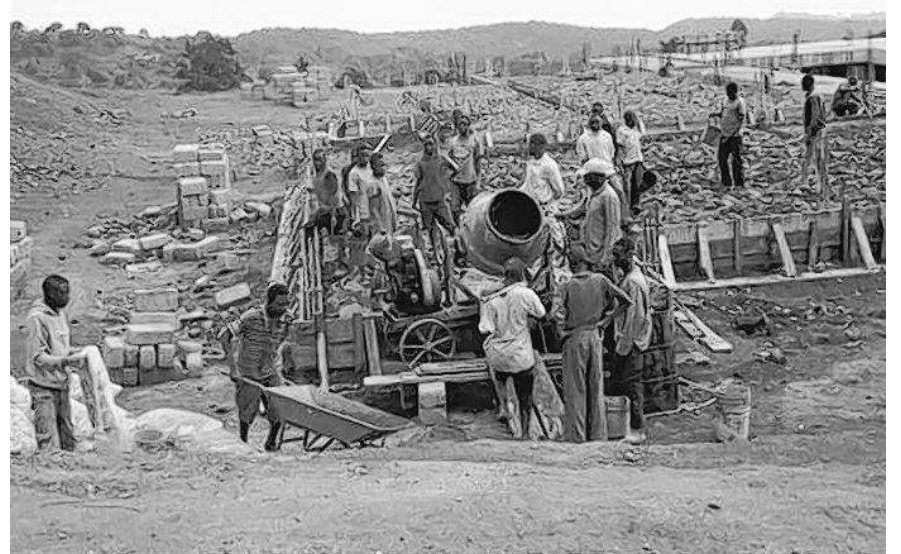
Es gibt noch jede Menge zu tun auf der Baustelle des Krankenhauses „St. Monica“.
